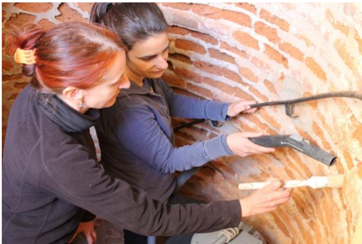
Imagen de los trabajos de limpieza y conservación realizados en el interior de una de las torres de titularidad municipal
